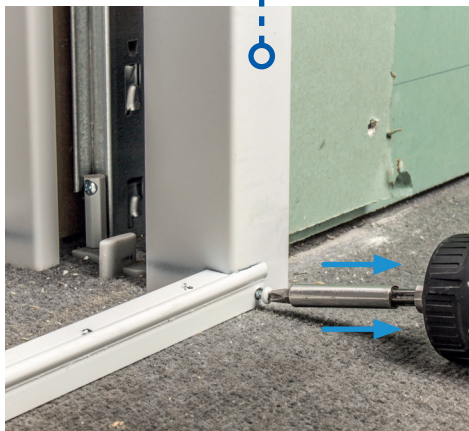
Untere Distanzhalter entfernen.
