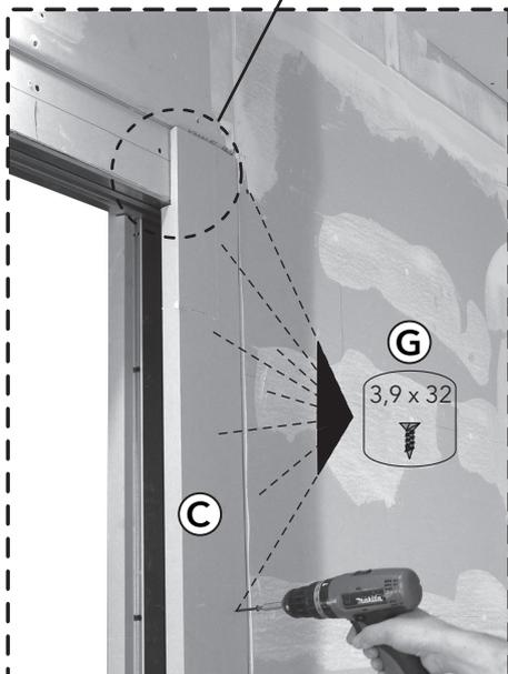
15 Querprofil zuschneiden und einseitig montieren.
