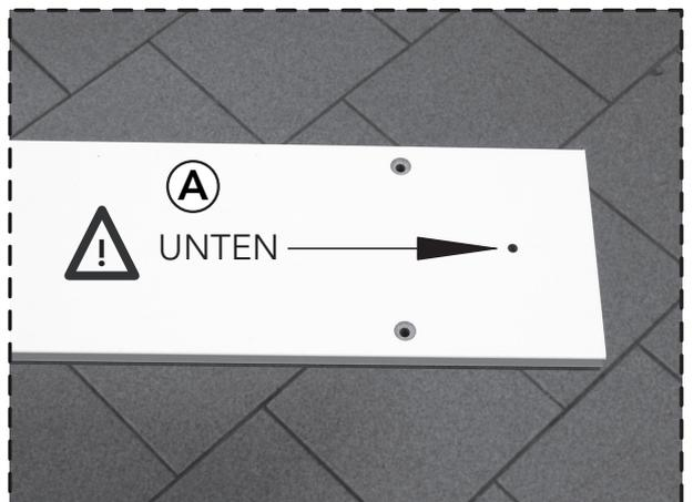
6 Montieren der Anschlagplatte auf das ECLISSE Profil.
